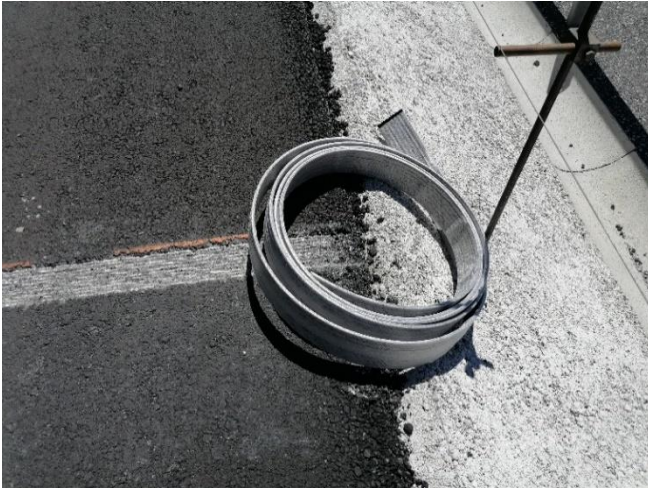
Figure 16. Flat drain (Germ. Flachdrän), Source: K. Hrapović, 2021
