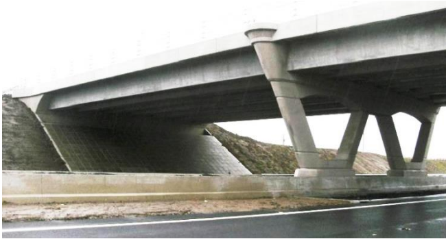
Слика 5. Изглед једно бетонског интегралног моста Извор: The Concrete Society
