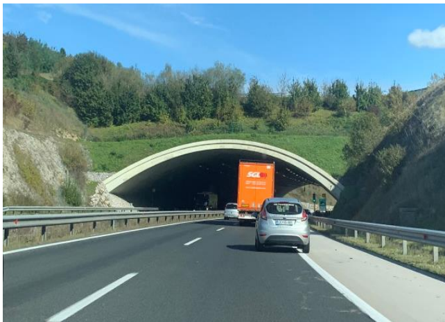
Слика 5. Зелени мост, Словенија
