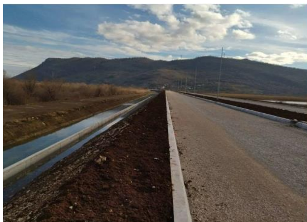
Слика 9. Парапетни зидови или усмјеривачи Извор: ekoportal.me
