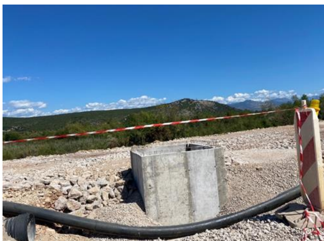
Слика 8. Изградња отвора за свјетлост на пролазима за животиње Извор: E3 Consulting
