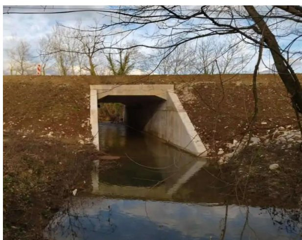
Слика 10. Пропуст за животиње и за пропуштање потока Извор: ekoportal.me
