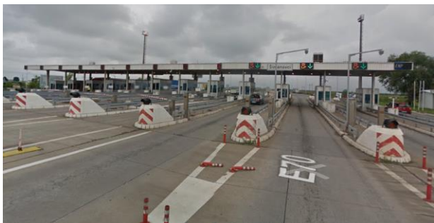
Slika 2. Prilaz ka naplatnim rampama u smeru ka Šidu
