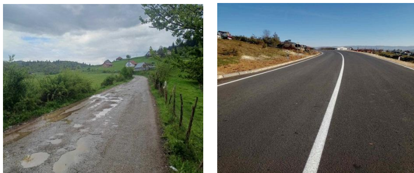
Slike 13, 13a, Deonica državnog puta IIA 205 Tutin – Vuča (pre i nakon izgradnje)
