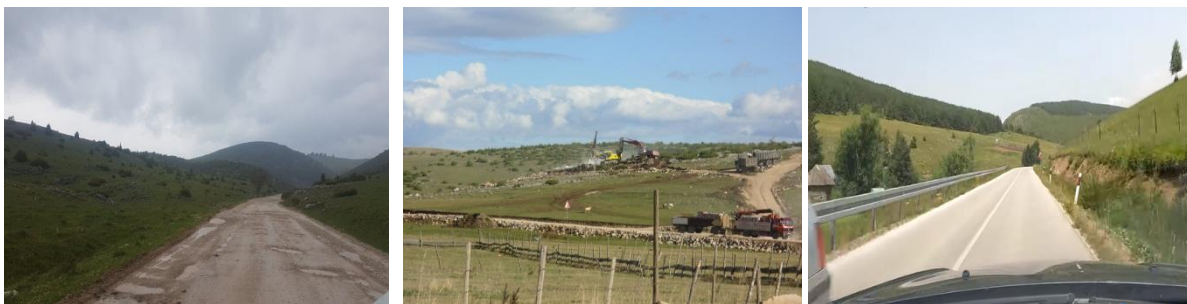
Slike 11, 11a, 11b. Deonica državnog puta IIA 202 Sjenica – Rakočki Bunari (pre, u toku i nakon izgradnje) Source: (Izvor, Arhiva Novi Pazar - put)
