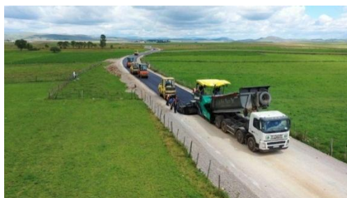
Slika 8. Asfaltiranje deonice državnog puta IIA 202
