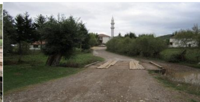
Slika 5. Drveni most na IIA 202 Source: Izvor: (Arhiva Novi Pazar – put)
