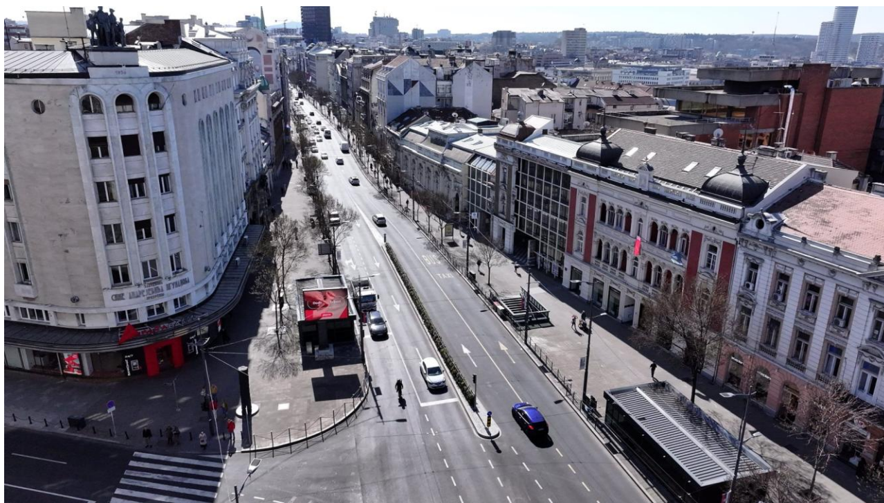
Slika 8. Ulica kralja Milana – ugrađen modifikovani SMA asfaltni sloj
