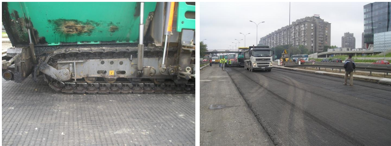
Slike 5 i 6. Kretanje mehanizacije po ugradjenoj geomreži
