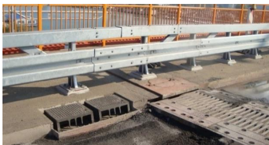
Slika 4. a) Dvostruki slivnici postavljeni neposredno uzvodno od dilatacione spojnice u okviru rekonstrukcije mosta 2012. godine. (b) Oštećeni i deformisani slivnici i deformisana dilatacija na kolovozu i na trotoaru mosta.
