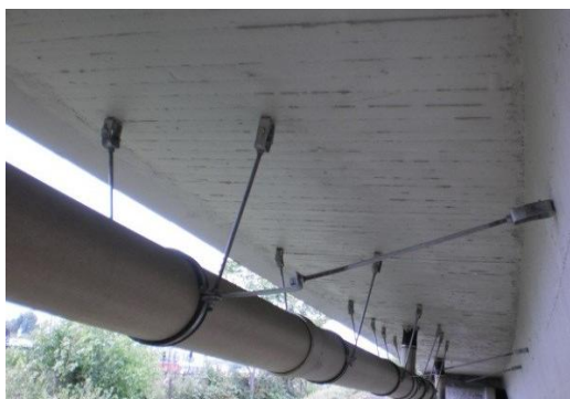
Slika 5. Kanalizacione cevi Ø300 su postavljene paralelno sa ivicama konstrukcije, definišući podužne nagibe cevi, kao i položaj cevi u poprečnom preseku konstrukcije mosta.
