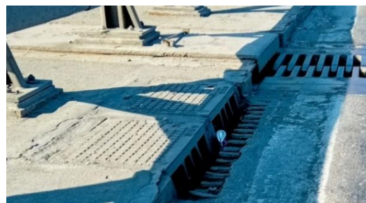
Slika 4. a) Dvostruki slivnici postavljeni neposredno uzvodno od dilatacione spojnice u okviru rekonstrukcije mosta 2012. godine. (b) Oštećeni i deformisani slivnici i deformisana dilatacija na kolovozu i na trotoaru mosta.
