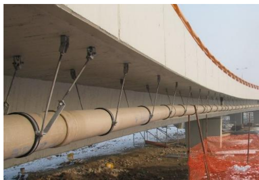
Slika 5. Kanalizacione cevi Ø300 su postavljene paralelno sa ivicama konstrukcije, definišući podužne nagibe cevi, kao i položaj cevi u poprečnom preseku konstrukcije mosta.
