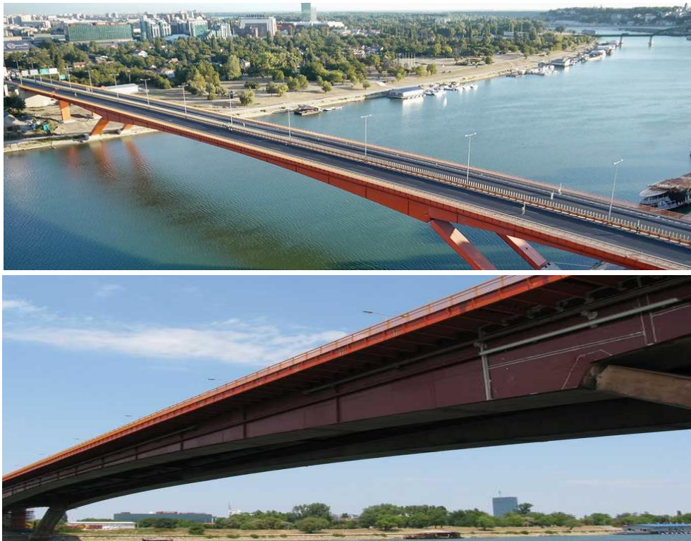
Slika 1. Most Gazela preko reke Save u Beogradu: pogled na centralni čelični deo mosta iz vazduha (gore) i pogled sa reke sa usidrenim cevovodom sa donje strane čelične konstrukcije (dole).
