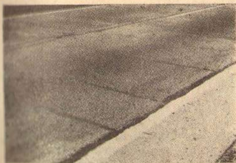
Сл. 15. Бетонски коловоз прекривен светлим асфалтом на аутопуту Франкфурт — Манхајм
