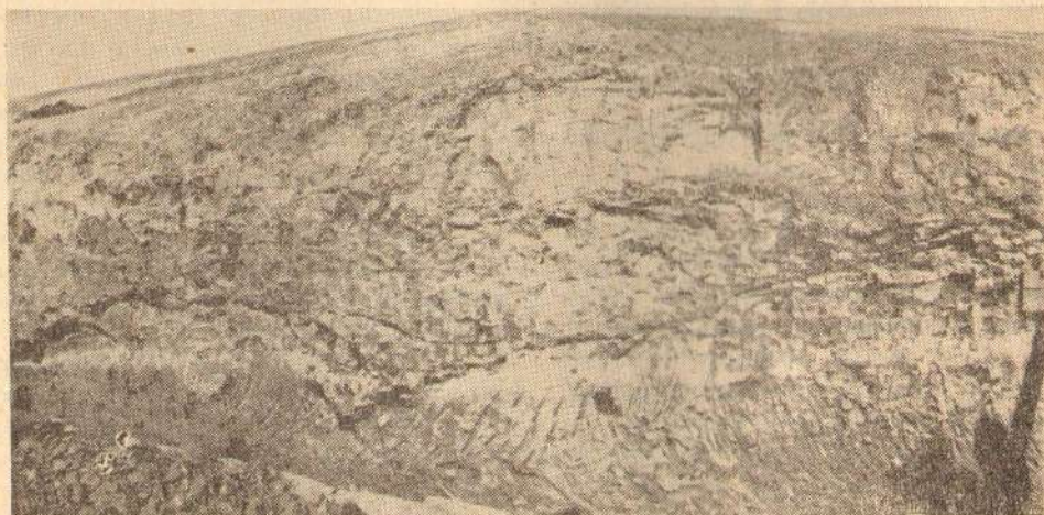
Сл. 3. а) Таласаста пукотина дужине око 25 м, у засеку за потпорни зид. Велики усек км 3 + 200, десна страна пута гледајући ка Великом Мокром Лугу. Пукотина је оријентисана према смедеревском путу; елементи пада 80/76, тј. према истоку, под стрмим углом. У истој тортонској глини.
