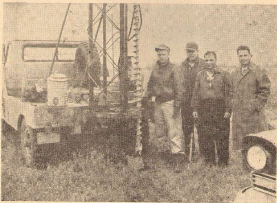
Сл. 1. Сондажни апарат са сврдлима
