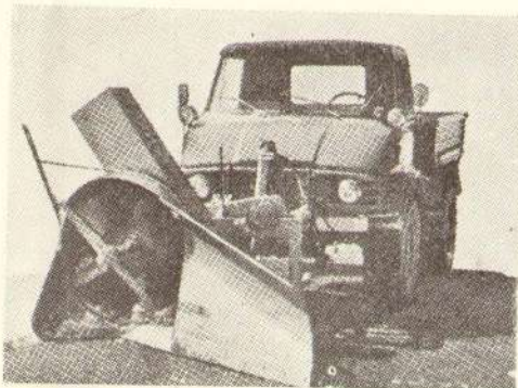
Сл. 20. Једнострука бочна турбина „Schmidt” монтирана на возилу „Unimog 406”. Радна ширина 1,80 м.
