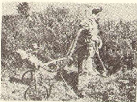
Сл. 3 Машина са кружном тестером за сечење шибља „La Nantaise”.
