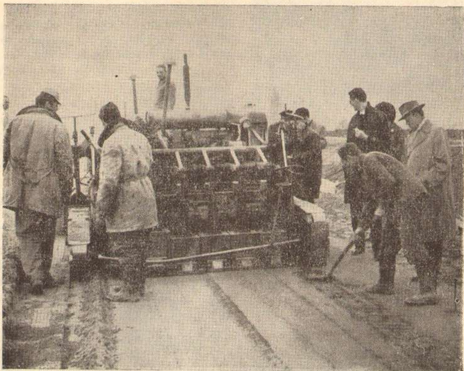
Детаљ са демонстрација — компактор Howard — 183 у изради горње подлоге
