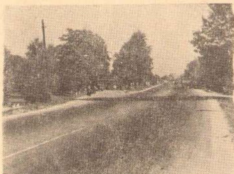
Сл. 2. Изглед пута после модернизације (деонице Пазарцик—Пловдив на 9 км испред Пловдива).
