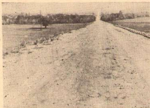
Сл. 8. Изглед деонице кружног пута са завршним доњим стројем, пред наношење тампонског слоја (км 39+700 ка км 39+000).
