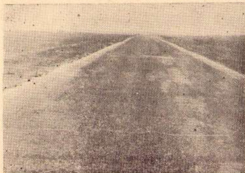
Сл. 6. Изглед девијације пута око Коларовграда после израде хабајућег слоја. Радови у току
