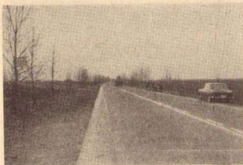
Sl. 8. Betonski kolovoz
