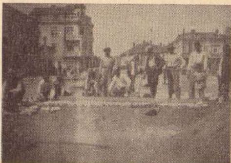
Sl. 4. Kontrola ravnosti površine kocke pomoću letve u Nišu
