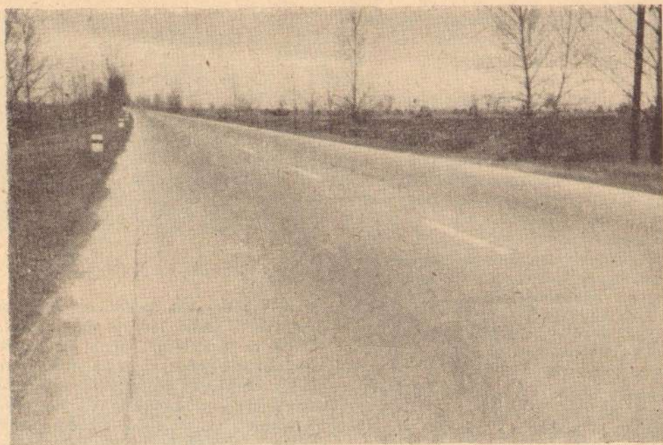
Sl. 7. Betonska ploča rađena 10. I. 1948. godine.
