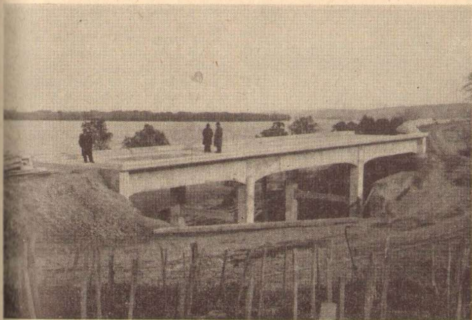
Sl. 1. Armirano betonski most ukupnog otvora 31,0 m preko potoka Lipovca, na novoj trasi puta Beograd—Novi Sad
