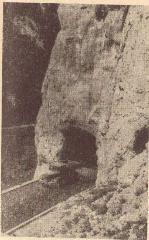
Sl. 18. Tunel bez portala, predstavlja nedovršen objekat
