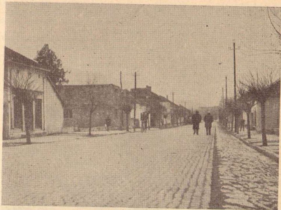
Sl. 28. Dobro stanje kolovoza sa zastorom od sitne kocke u Beloj Palanci
