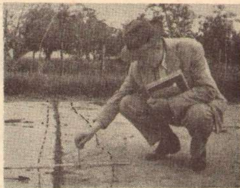
Sl. 6. Pojačano habanje na poprečnim spojnicama i stvaranje „korita“
