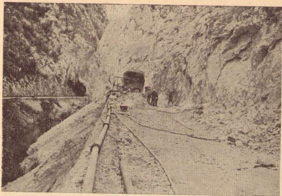
Sl. 22. Bušenje tunela u steni u punom profilu sa našim „džembom“
