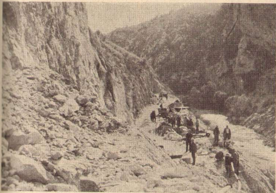
Sl. 12. Izvanredan pejzaž u Sićevačkoj klisuri, obimni radovi u steni
