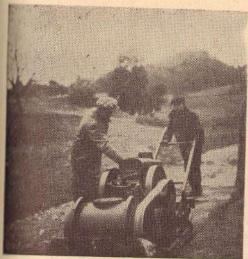
Sl. 9. Vibraciona mašina za nabijanje zemljanih nasipa i šljunkovitih slojeva na deonici Dolac—Bela Palanka
