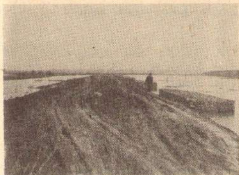
Sl. 5. Raskvašen nasip na km 7 + 500. Usled visokog vodostaja r. Dunava voda je prodršla ispod odbrambenog nasipa i izlila se s obe strane puta. Desno: figure lomljenog kamena za podlogu puta.
