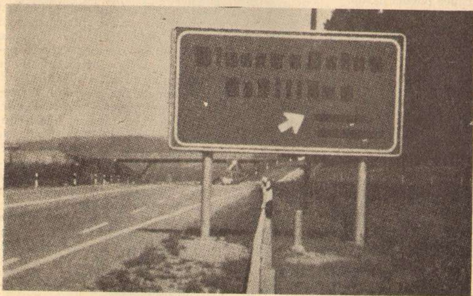
Sl. 3 — Pred ogradom stub. Ograda povećava opasnost da vozilo udari u stub
