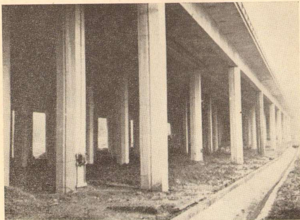
Сл. 3. и 4. — Изглед два виадукта одоздо. Виде се префабриковани елементи коловозне конструкције од преднапрегнутог бетона
