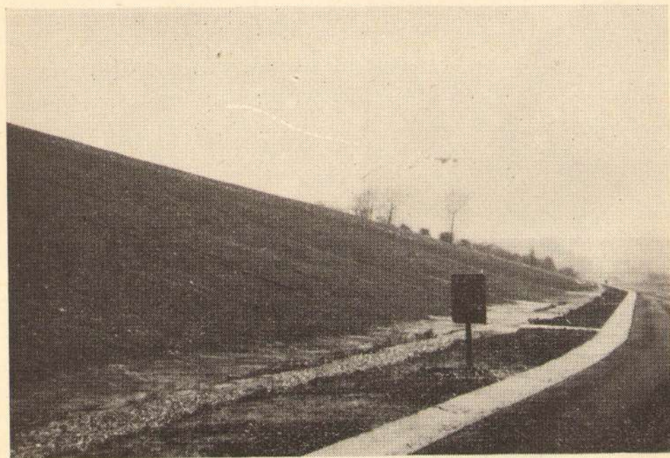
Сл. 7. — Изглед косине, дренажног канала затрпаног шљунком и везе ригола са ревизионим шахтом
