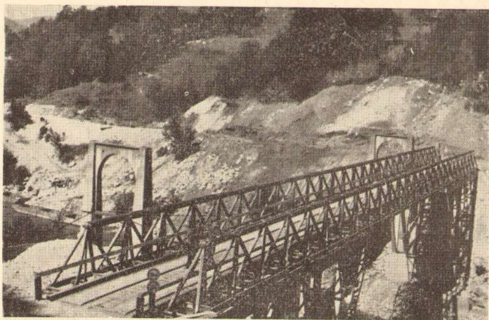
Сл. 5. — Привремени мост преко р. Таре - конструкција Бејли
