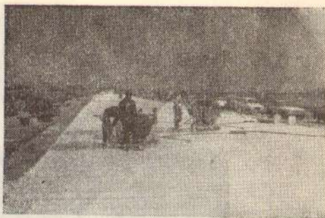
Сл. 8. — Сечење попречних спојница у бетону помоћу специјалних машина
