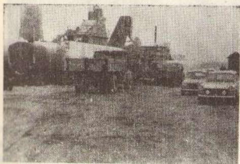
Сл. 11. — Производња асфалтних мешавина у машини капацитета 120/ч.
