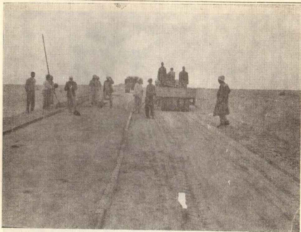
Сл. 8. — Сабијање трупа и постелице пута пнеуматичким ваљком
