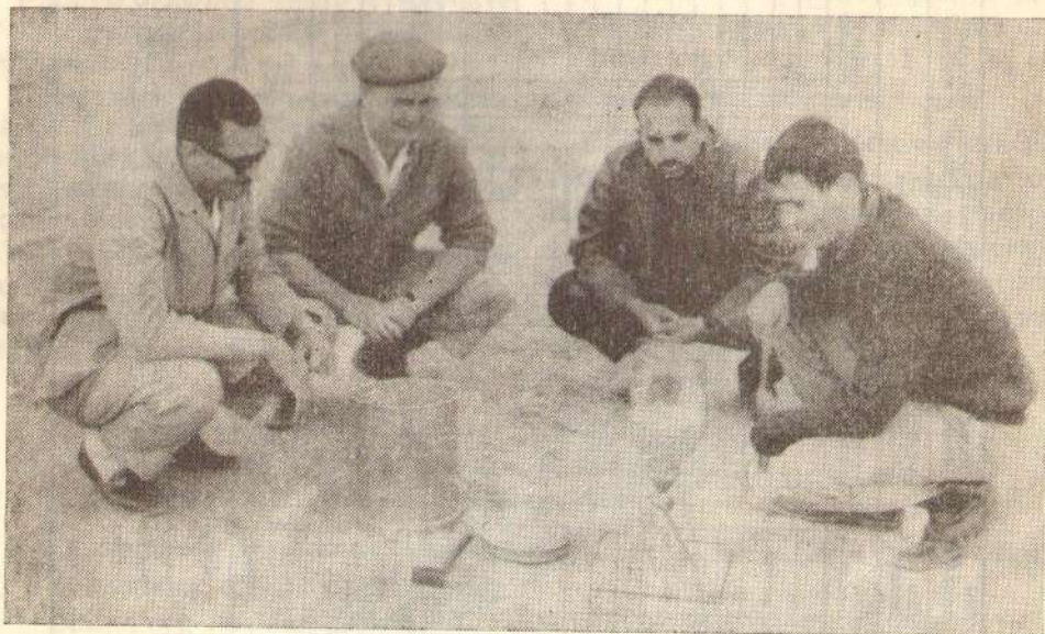
Сл. 5. — Контрола збијености постељице волуметријском методом (песак)
