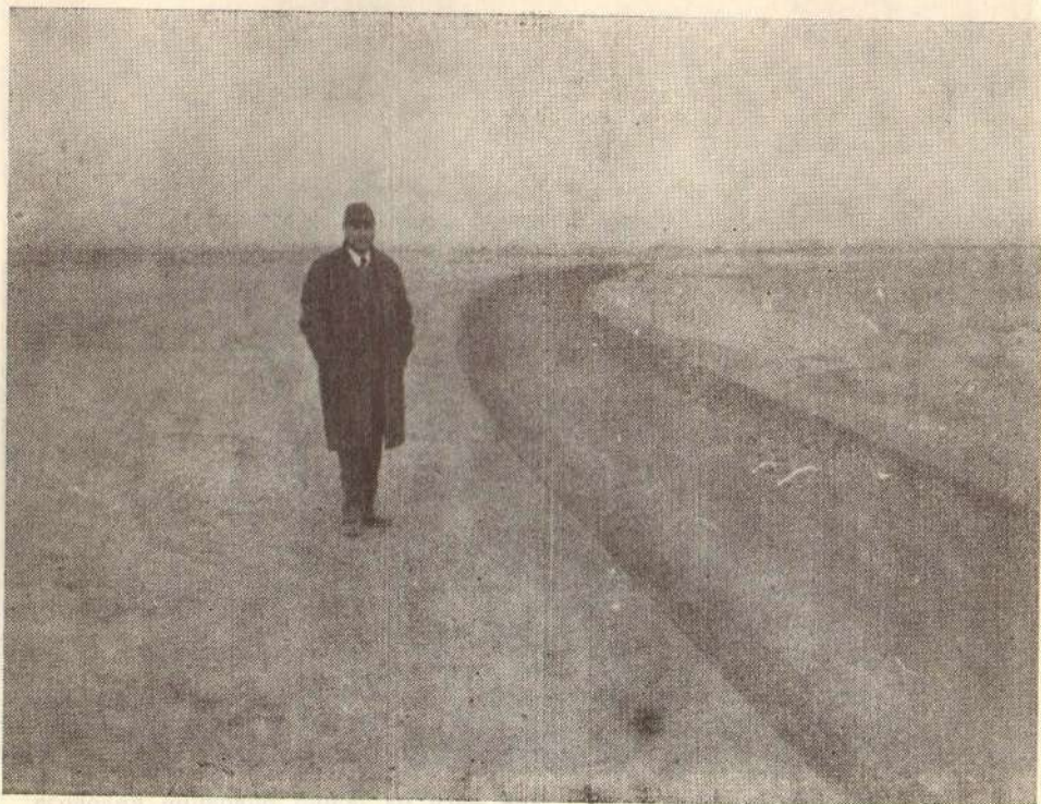
Сл. 12. — Завршен потез пута са коловозом од битуменске стабилизације
