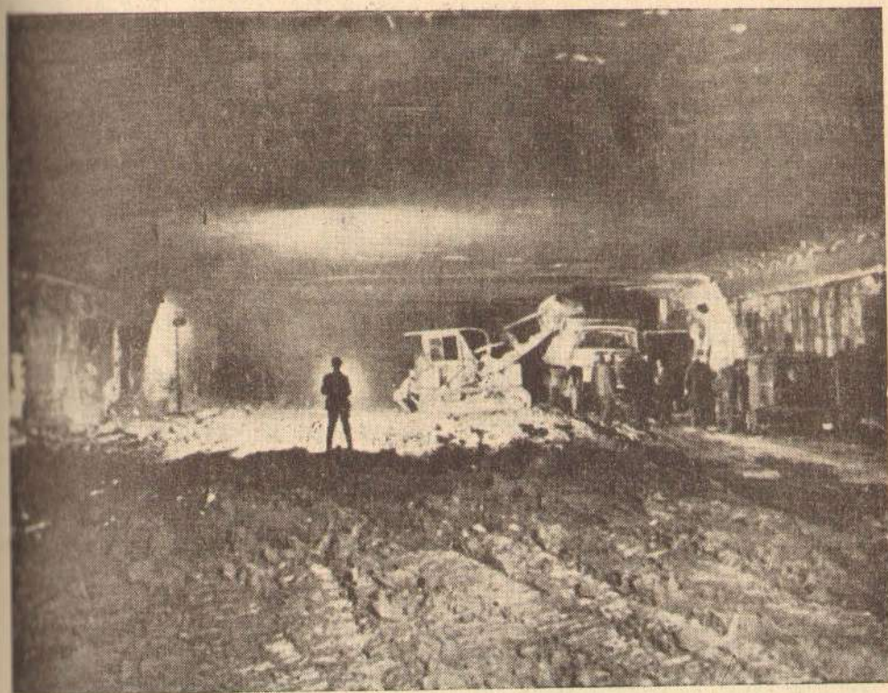
Сл. 44. — Извршење земљаних радова механичким путем у тунелу „Cours la Reine — Cours Albert I“.
