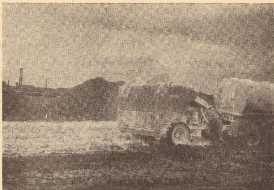
Сл. 11. — Разастирање живог креча специјалним машинама при изради насипа са влажном земљом.
