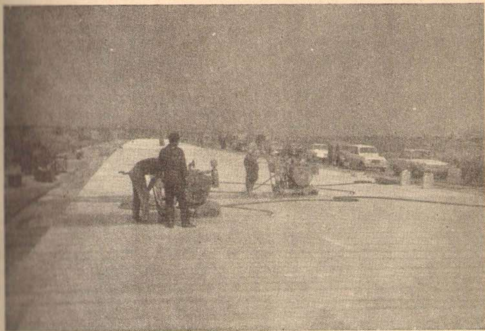
Сл. 16. — Машине за сечење подужних и попречних спојница у очврслом бетону на ауто-путу Париз — Нормандија.
