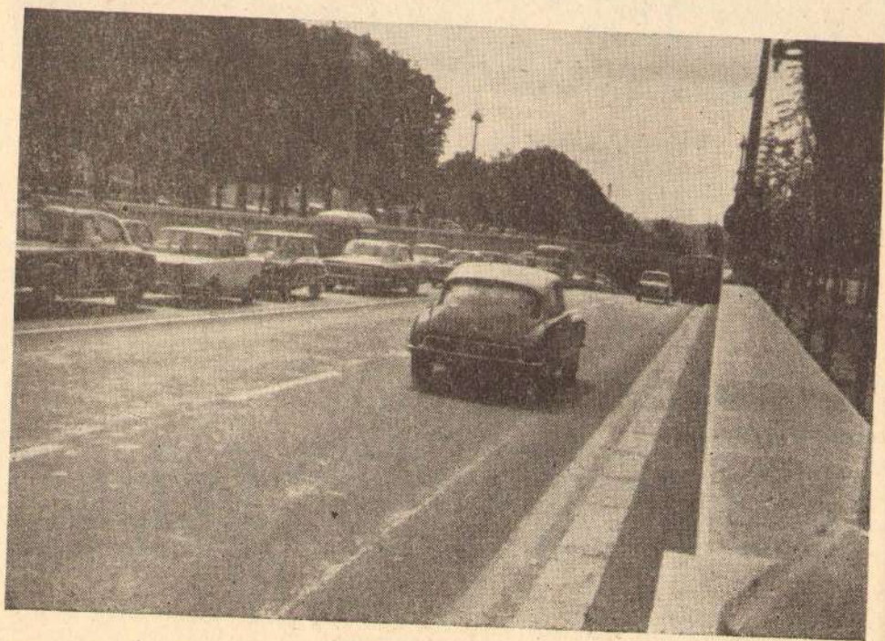
Сл. 45. — Улаз у тунел „Cours la Reine — Cours Albert I“, са лошом нивелетом и малим полупречницима вертикалних кривина.
