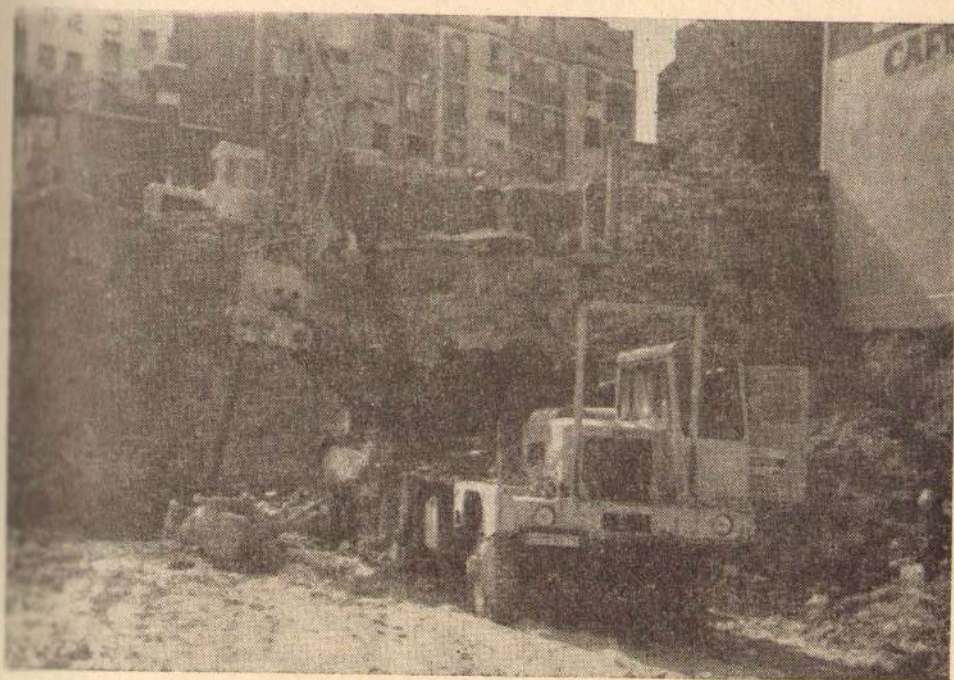
Сл. 38. — Машина за бушење земље за израду ливених бетонских стубова.
