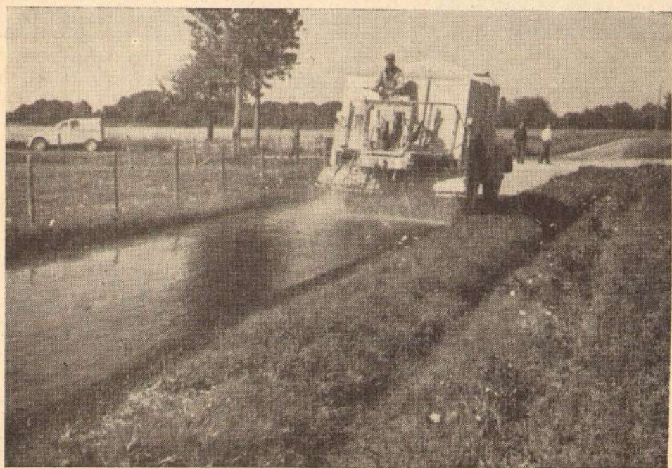
Сл. 12. — Разастирање „допа“ при изради површинске обраде помоћу специјалног уређаја, уграђеног на камиону за разастирање камене ситнежи.
