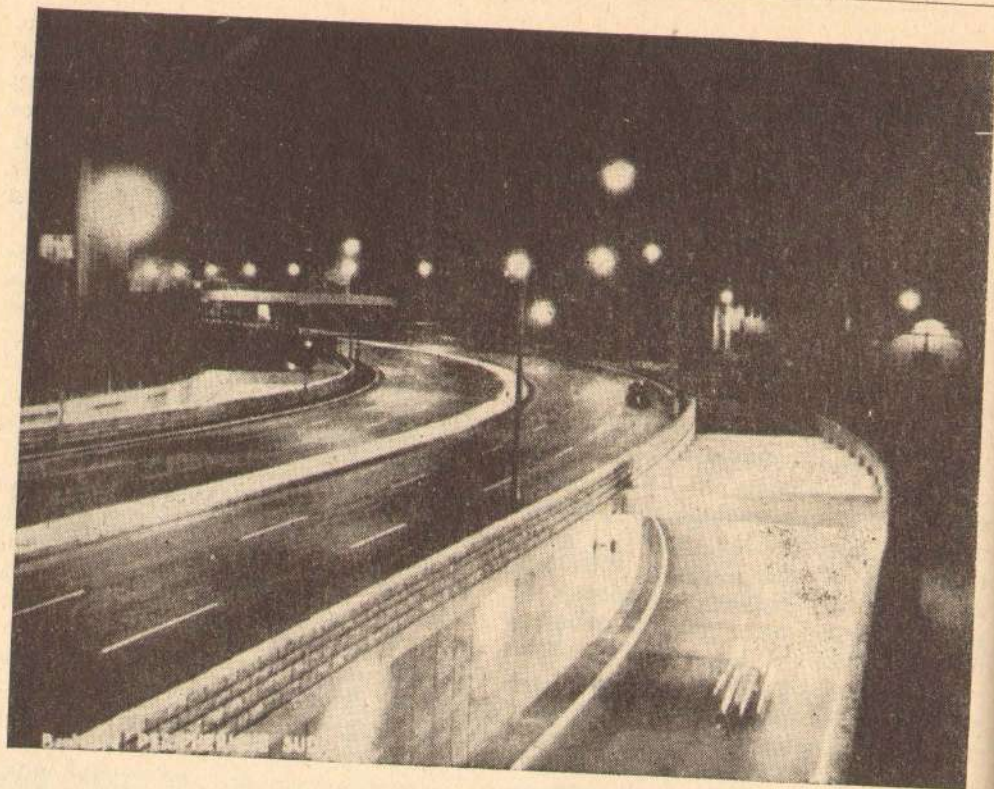
Сл. 41. — Осветљење једне деонице периферијског булевара и тунела са видљивим контрастом осветљења у тунелу.
