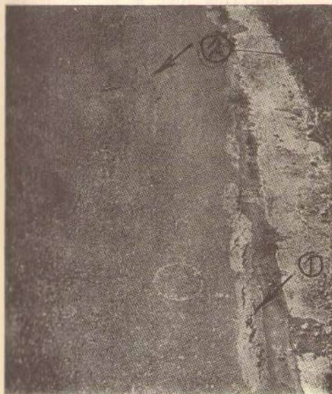
Сл. 7 — Појава подужних прслина на коловозу због одвијања — померања ивичних трака у хоризонталном или вертикалном смислу
