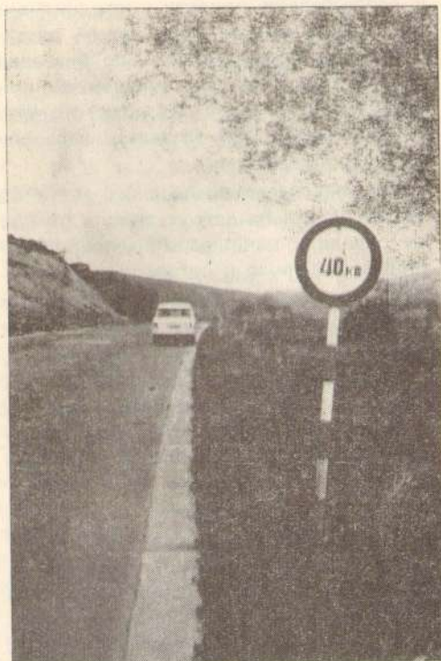
Сл. 2 Пример неправилног постављања допунских табли уз знак
