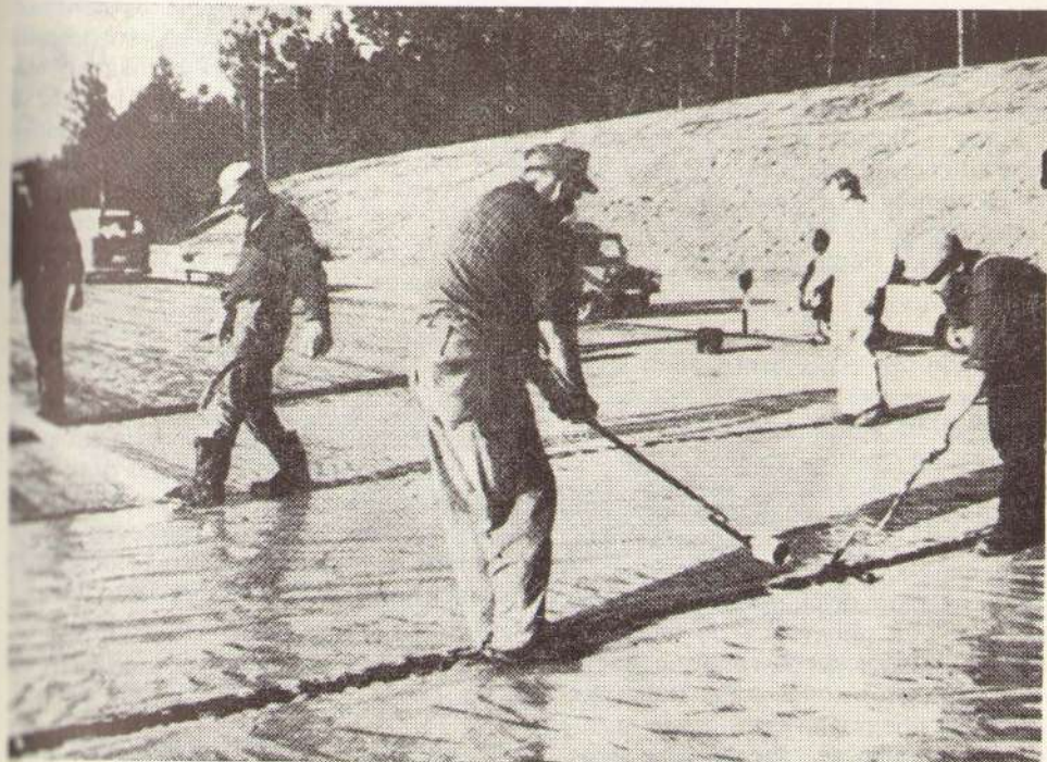
Сл. 30 — Постављање специјалних фолија преко постељице ради спречавања капиларног пењања подземне воде
