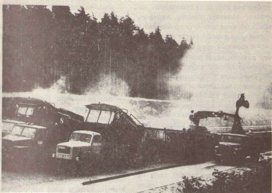
Сл. 35 — Гарнитура машина за уграђивање ливеног асфалта са специјалним камионима за транспорт асфалтне масе
