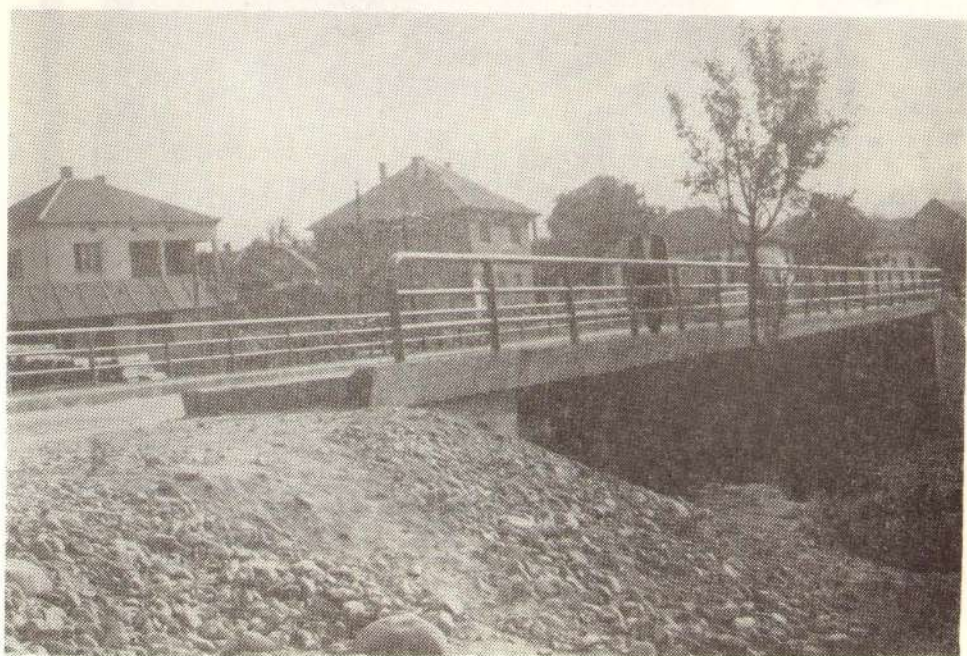
Мост на путу 124/II
