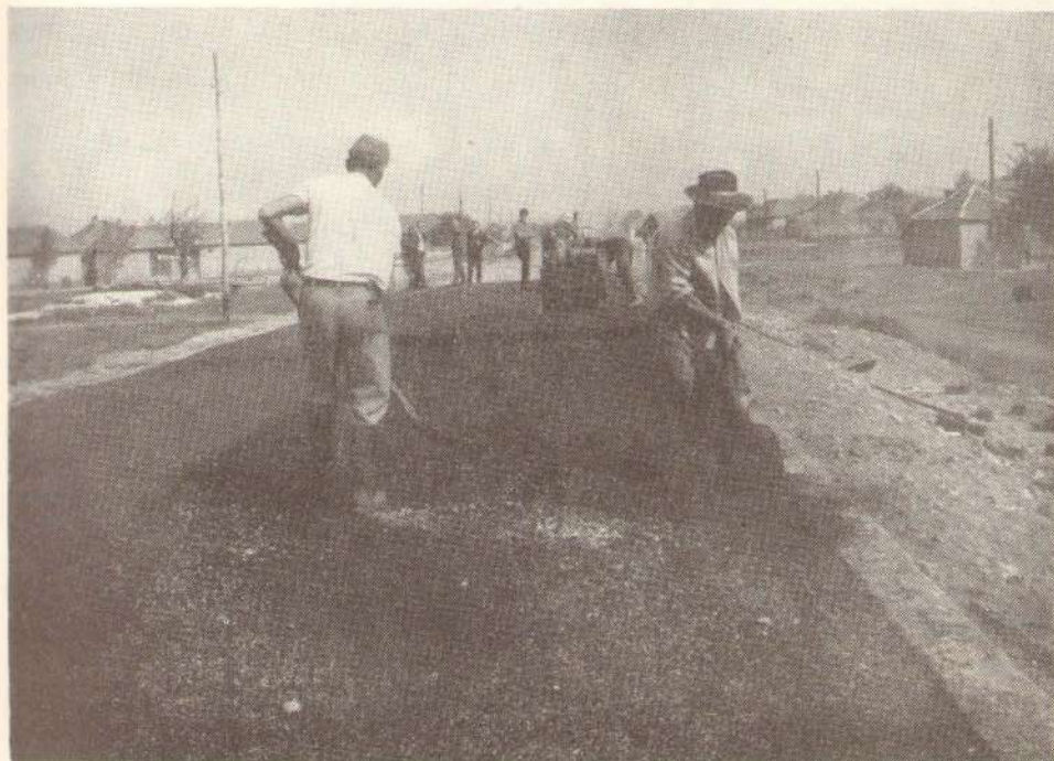
Примитивно уграђивање асфалтне масе на путу Лесковац — Лебане
