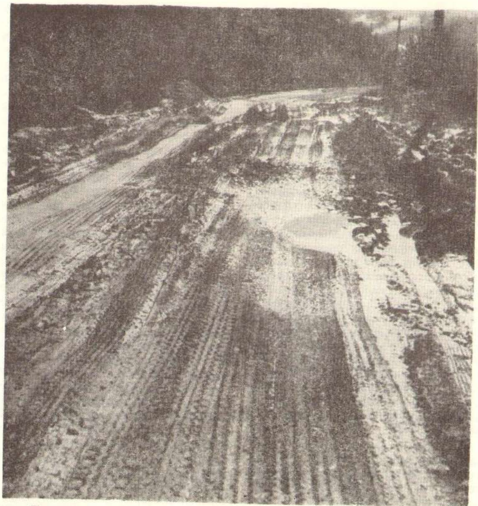
Коловоз од туцаника без одговарајуће заштите од тешких возила у периоду одмрзавања
