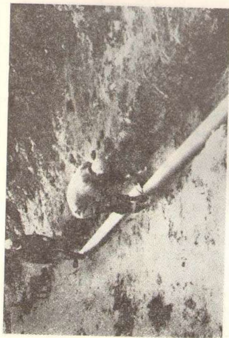
Сл. 5 Спајање RAUDRIL-D цеви може извршити један радник, боље је ако су двојица
