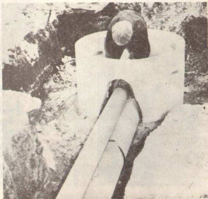
Сл. 9 — Системи дренаже „цев на цев” прикључен на канализациони шахт
