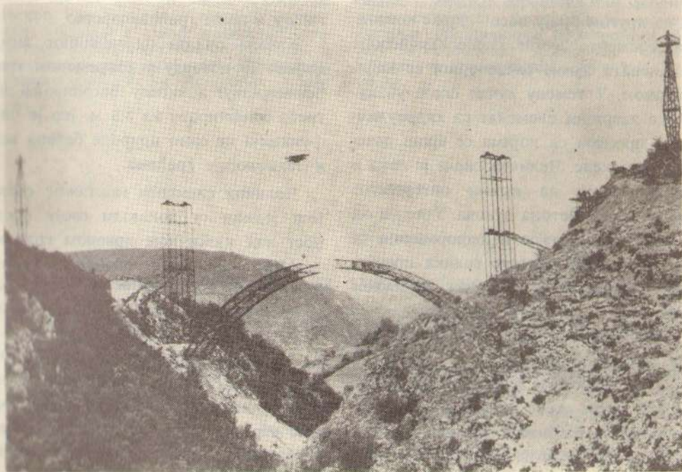
Сл. 4. Монтажа лучне скеле на мосту „Мехов крш“
