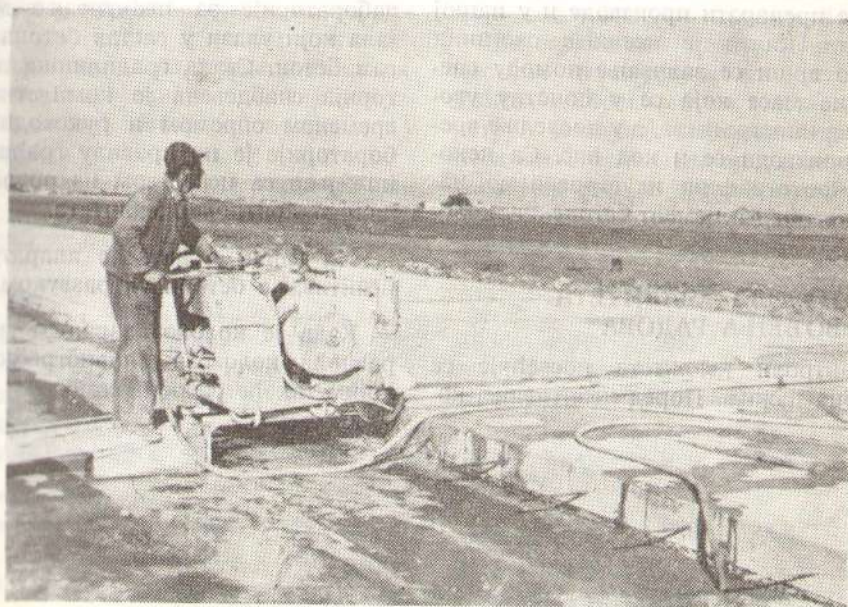
Сл. 3 — Исецање бетона
