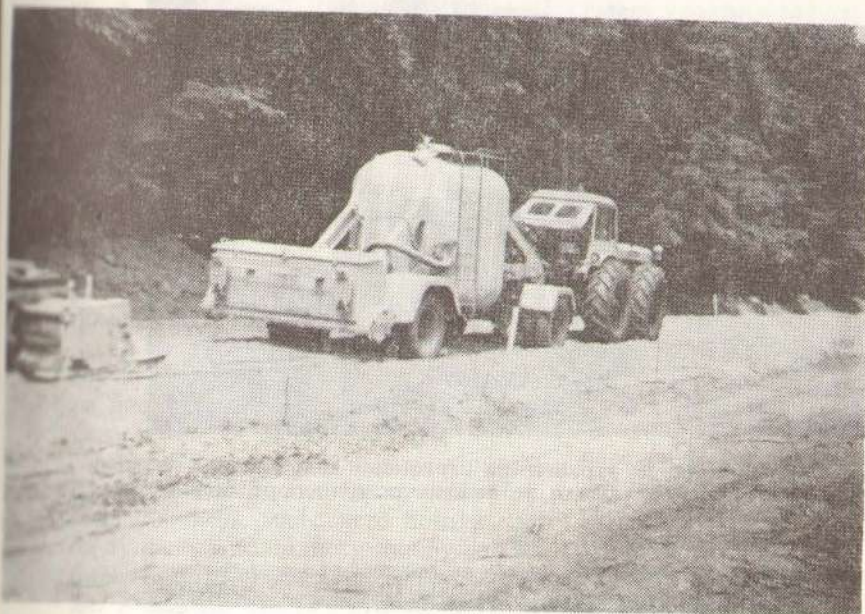
Сл. 1 — Транспорт цемента и уређај за разастирање
