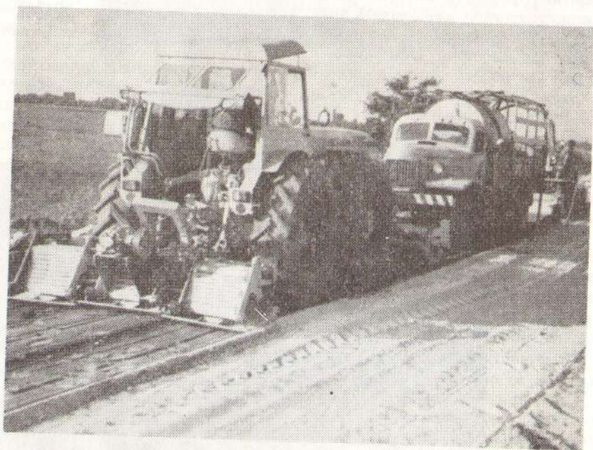
Сл. 4 — Ред плочастих вибратора који је уграђен на предњем и стражњем DUTRA-тегљачу сабија успешно влажну мешавину тло-цемент
