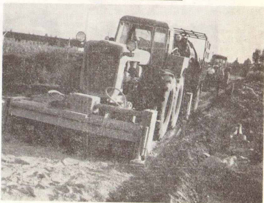
Сл. 1 — Транспорт цемента и уређај за разастирање
