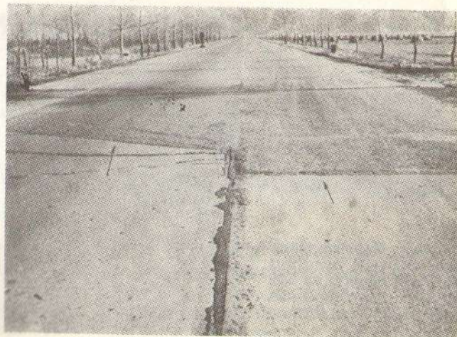
Слика 8. Подужне и попречне пукотине које се јављају у већем броју на бетонској плочи — тип 3.1.
