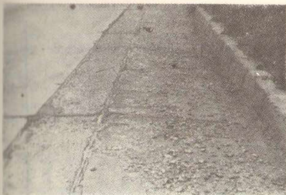
Слика 10. Љуспање површинског дела ивичних трака и ригола — тип 4.1.
