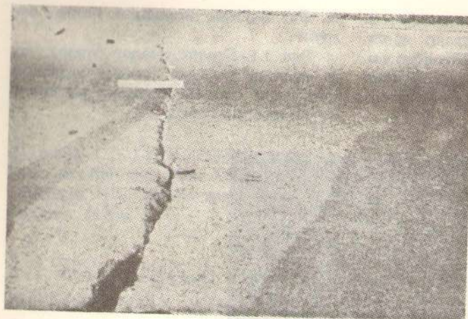
Слика 3. Попречне пукотине обично око средине дужине плоче, отвора 0,1 до 8 цм — тип 1.3.
