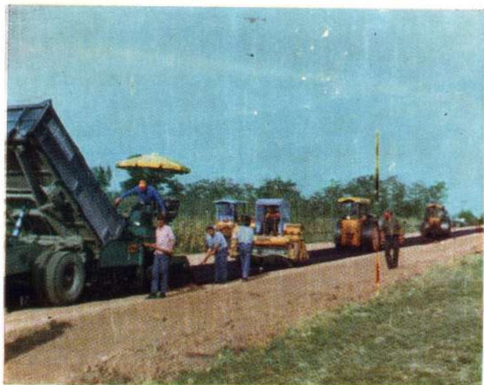
Сл. 5 — Савремена механизација за израду асфалтних коловоза
