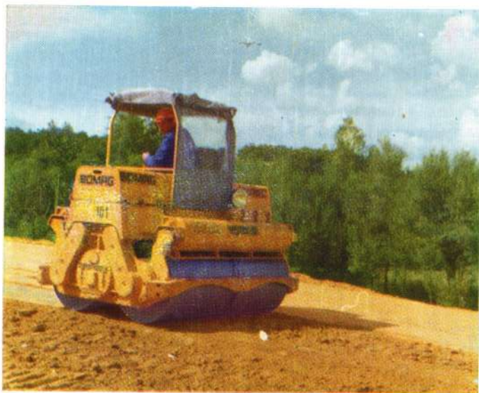
Сл. 2 — Набијање постељице вибровлачком
