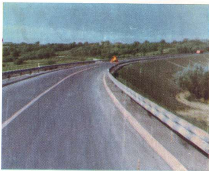
Сл. 8 — Завршен део пута
