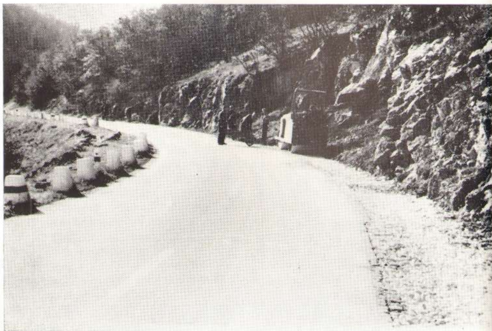
Сл. 11 — Затрпавање дубоких канала на Златиборском путу
