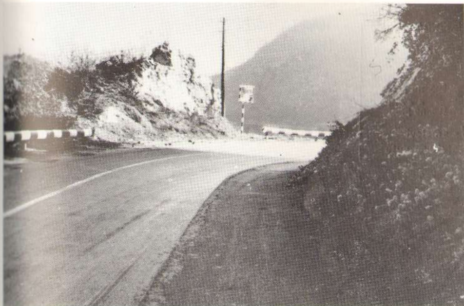
Сл. 8 — Проширење коловоза и огледало на Златиборском путу
