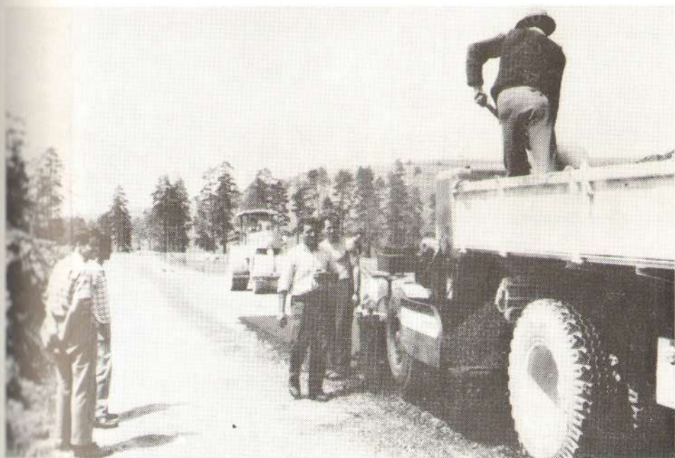
Сл. 3 — Пресвлачење оштећеног асфалног коловоза на путу Златибор — Нова Варош
