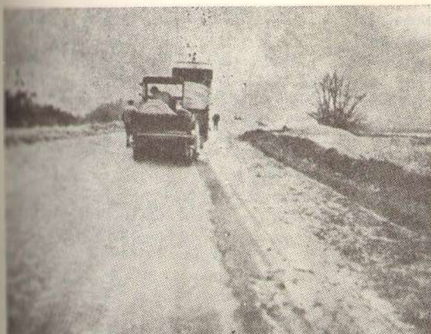
Сл. 6 — Посипање песка непосредно по разастирању — прскању првог слоја емулзије
