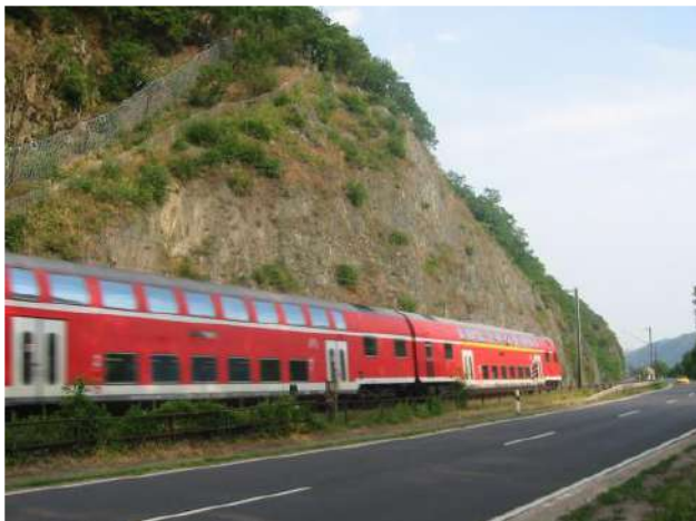
Slika 19. Zaštita i pruge i ceste fleksibilnom barijerom
