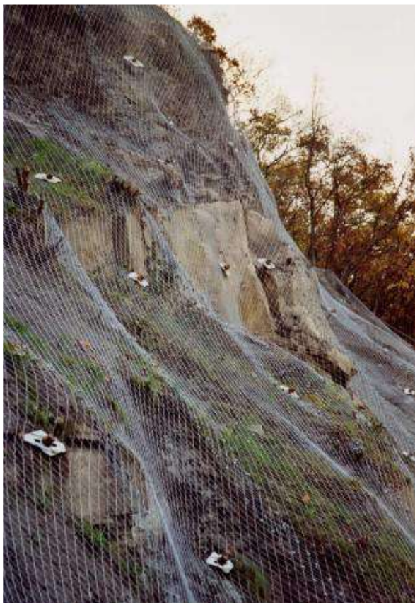
Slika 11. Pravilno postavljena mreža na pokosu
