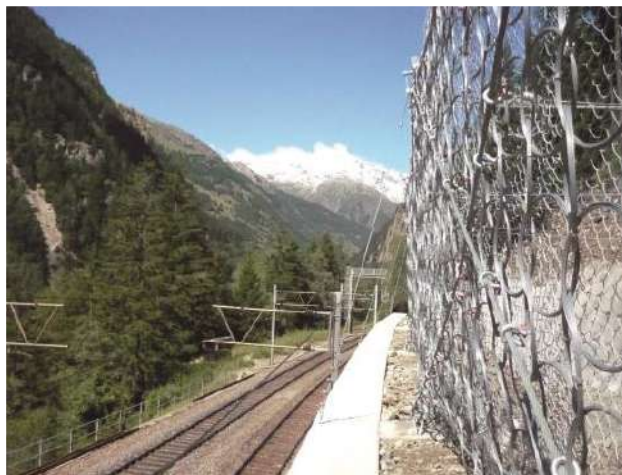
Slika 20. Zaštita pruge fleksibilnom barijerom
