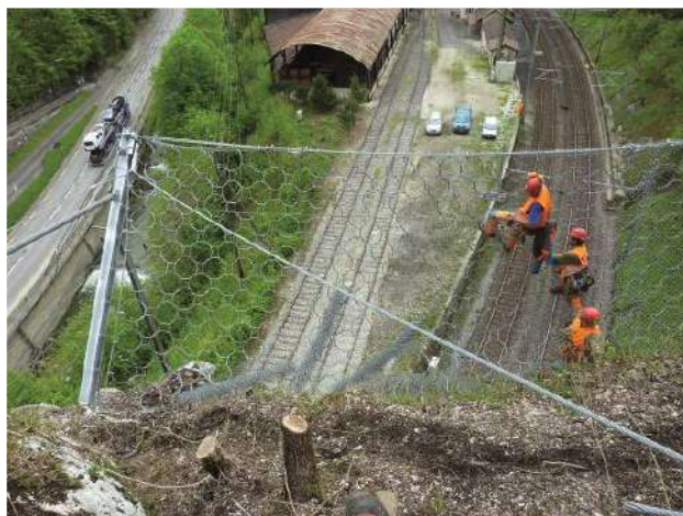
Slika 22. Instalacija barijere na portalu tunela
