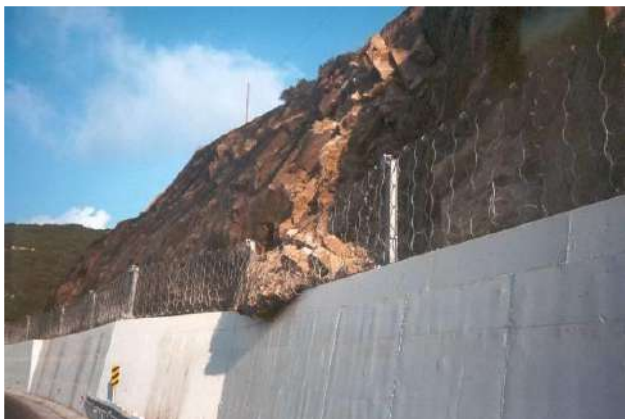
Slika 17. Barijera na betonskom zidu
