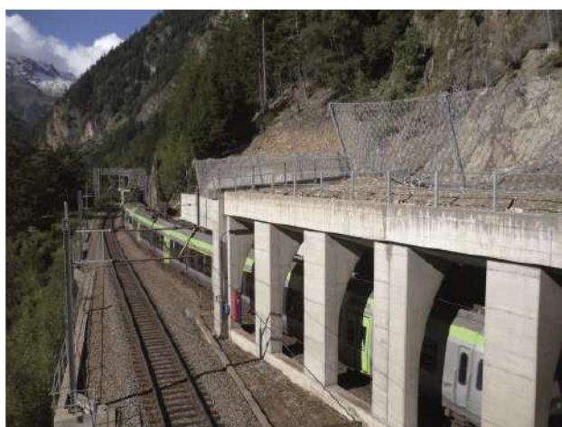
Slika 21. Pored betonske galerije, potrebna je i zaštita fleksibilnom barijerom
