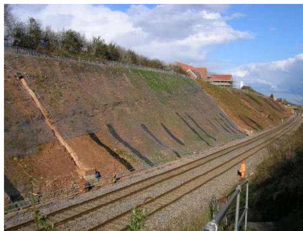
Slika 12. Instalacija Tecco® sustava uz prugu
