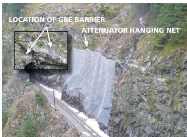
Slika 18. Zaštita predusjeka tunela
