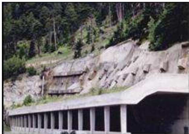
Slika 9. Skupo rješenje betonskom galerijom
