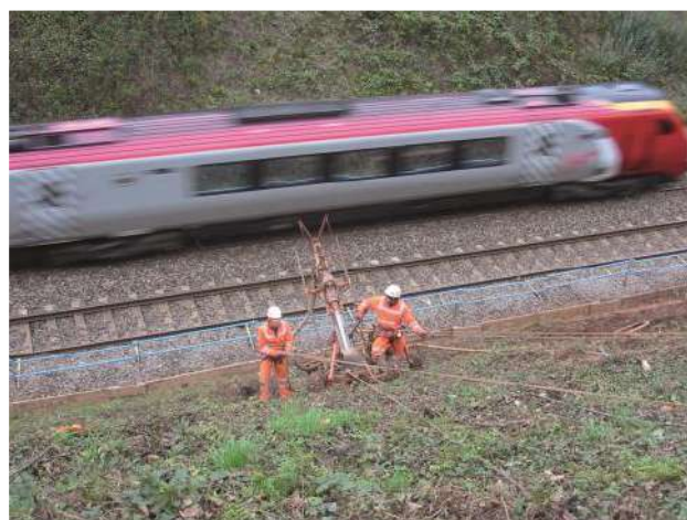
Slika 14. Instalacija je moguća bez zaustavljanja prometa
