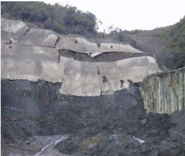
Slika 5. Raspadnut torkret na pokosu u Meksiku
