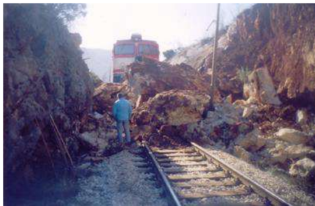
Slika 2. Primjer odrona kamena na željezničku prugu
