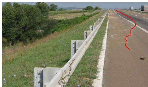
Слика 1. Активно клизање високог насипа на Е-75 код села Бобовиште
