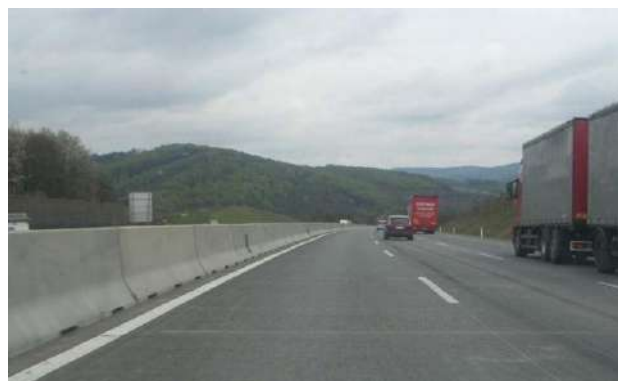
Slika 1. Betonska montažna zaštitna ograda nivo zaštite H4b u srednjoj traci autoputa – jedan red
