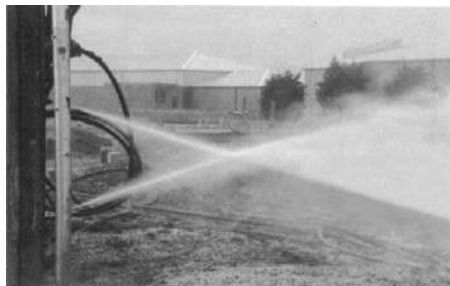
Слика 1. Cross-jet grouting (сет двојних млазница са укрштајућим дејством), лево и шематски приказ извођења поступка „jet grouting“ одоздо навише, десно
