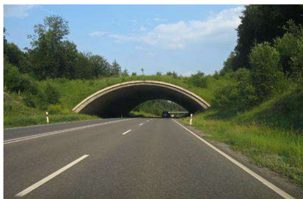
Слика 3. Пејзажни мост изнад аутопута у Боблингему, Немачка [3]
