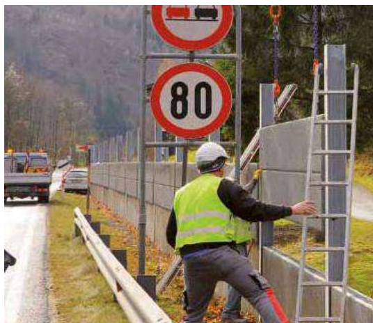
Slika 10. Primena Phonobloc ograde za zaštitu od buke na cestama
