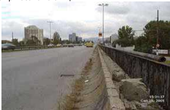
Слика 1. Неадекватно одржаван појас пута
