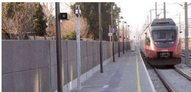
Slika 8. Primena Phonobloc ograde za zaštitu od buke za brzine vlakova i do 200 km/sat.
