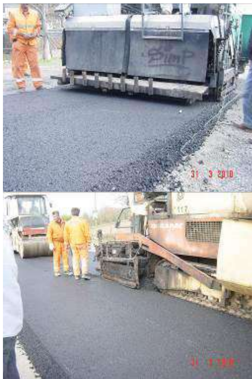
Слика 10. Локални пут, Сурчин, битуменизирани носећи слој BNS 22A
