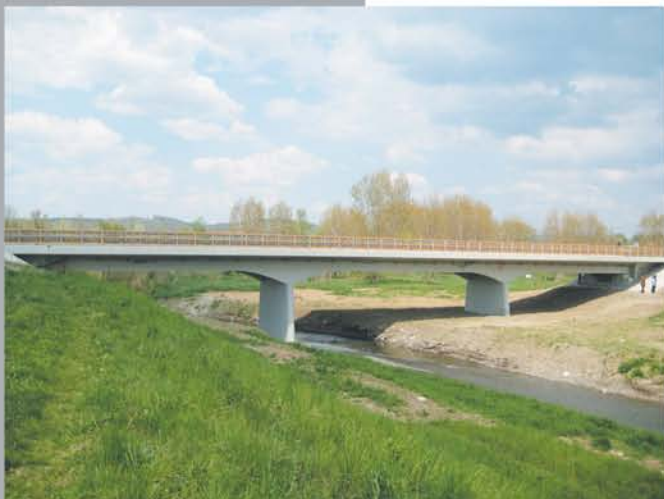
МОСТ ПРЕКО РЕКЕ ЧЕМЕРНИЦЕ - ДЕОНИЦА ПУТА ЧАЧАК - КРАЉЕВО ( технички преглед )
