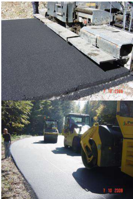
Слика 9. Локални пут : Голијска река, асфалт бетон АБ 11с
