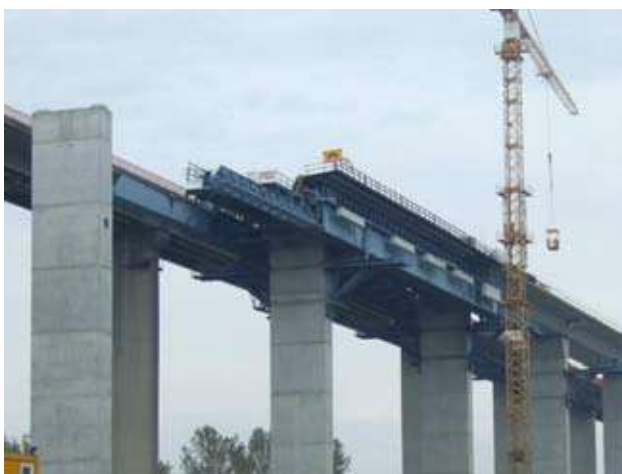
Slika 17: Movable Scaffolding System za izgradnju gornjeg stroja na levoj obali (25.10.2010)
