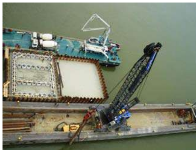
Slika 11: Betoniranje šablona za bušenje šipova u reci (17.09.2009)
