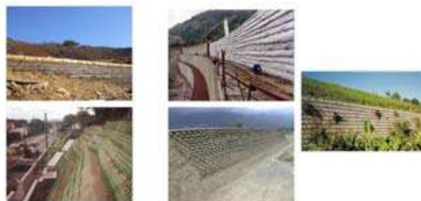
Slika 2: Varijante izgleda zida armiranog nasipa
