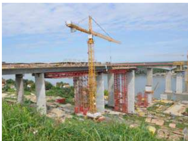
Slika 18: Teška skela za izgradnju gornjeg stroja na desnoj obali (03.09.2010)
