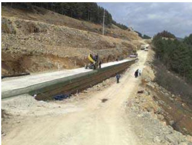
Slika 11: Izrada 6 sloja armiranog nasipa
