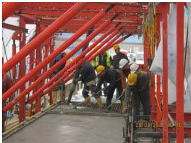
Slika 21: Betoniranje pešačkih staza korišćenjem pokretne skele (28.03.2011)
