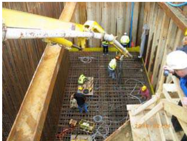
Slika 15: Betoniranje naglavne grede (04.02.2010)
