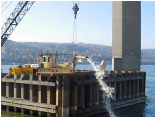
Slika 12: Ispumpavanje peska iz priboja (13.11.2009)
