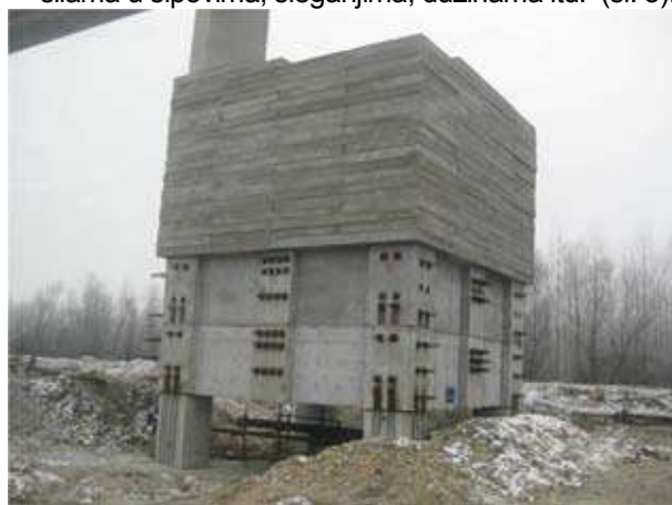
Slika 3: Probni šip sa betonskim pločama koji simuliraju opterećenje (07.01.2009)
