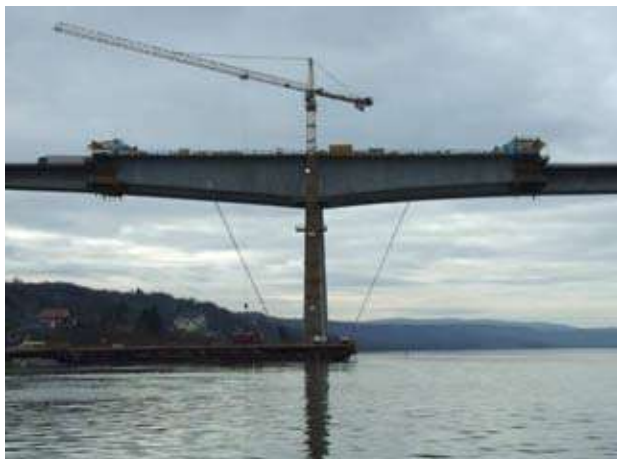
Slika 20: Privremeni kablovi za ukrućenje glavnog nosača (14.01.2011)
