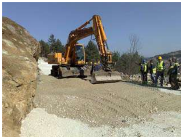
Slika 8: Razastiranje materijala
