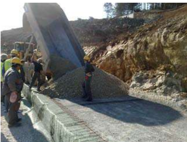
Slika 7: Nasipanje materijala
