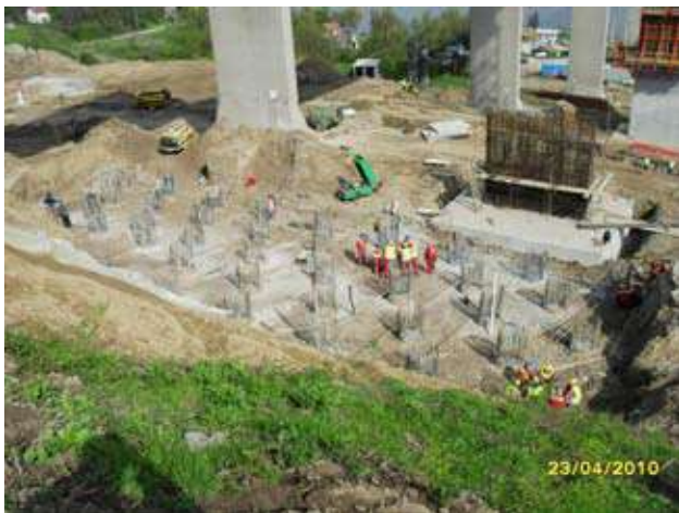
Slika 9: Izrada konstrukcija za stabilizaciju klizišta na desnoj obali Dunava
