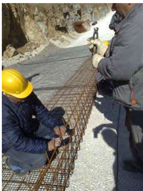
Slika 6: Postavljanje zelene i čelične armaturne mreže
