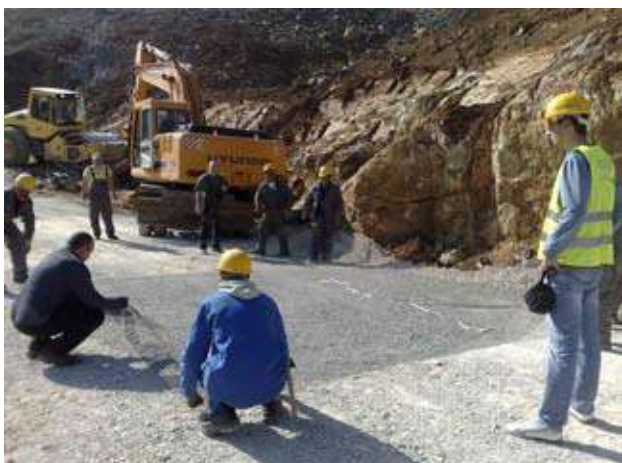
Slika 5: Razastiranje geomreže na donji sloj
