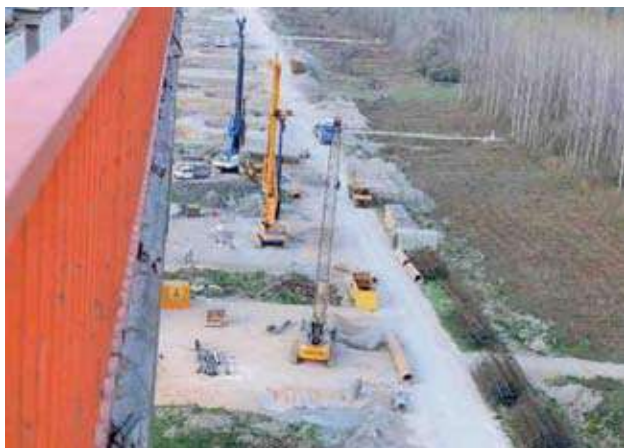
Slika 8: Izgradnja šipova na levoj obali (27.08.2008)
