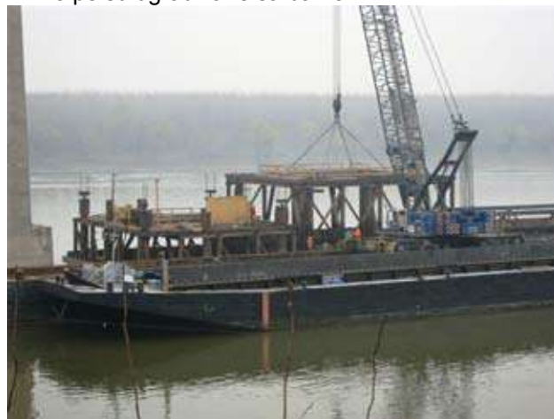
Slika 10: Postavljanje pomoćne konstrukcije za ugradnju talpi (01.04.2009)
