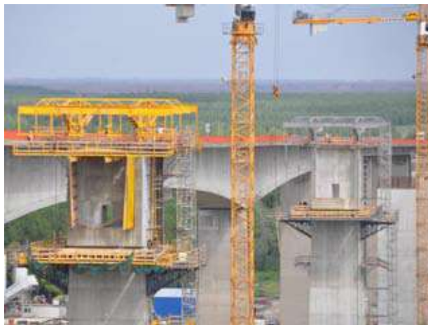
Slika 19: Montaža „Form Traveller“ skela za konzolnu gradnju, na vrhovima stubova u reci (03.09.2010)
