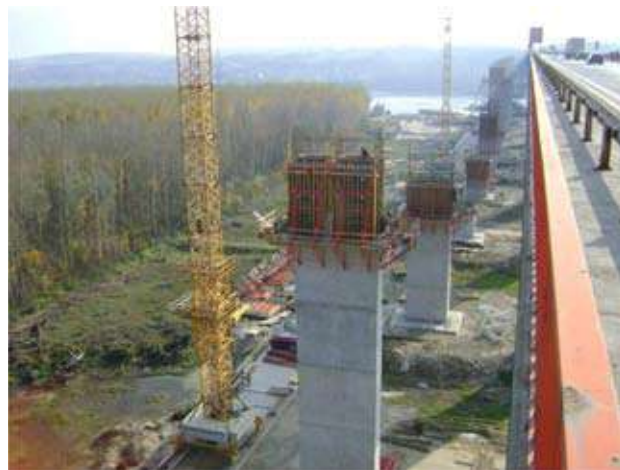
Slika 16: Izgradnja stubova na levoj obali korišćenjem prenosne oplata (12.10.2009)
