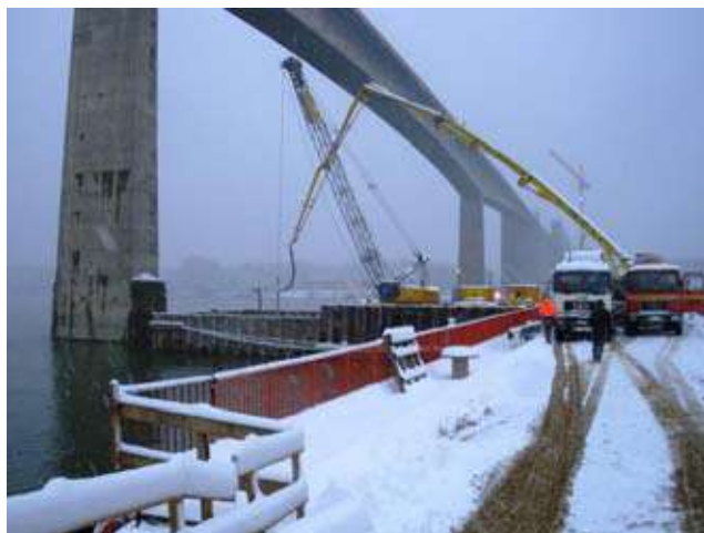
Slika 13: Betoniranje podvodnog betona u osi 43 (15.12.2009)
