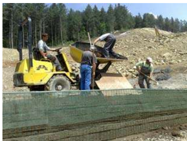
Slika 9: Sipanje humusnog materijala sa semenima trave
