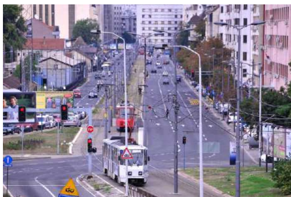
Слика 4. Савска улица, у експлоатацији, после завршене реконструкције (прве фаза) (ЦИП)
