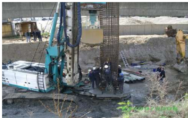
Слика 2. Постављање армиранобетонског шипа за стуб железничког моста (Извор: Из документације ЦИП-а)
