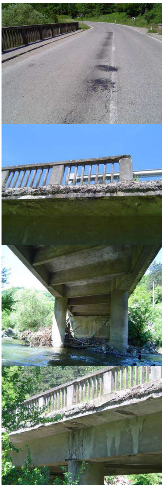
Слика 1. Постојеће стање моста
