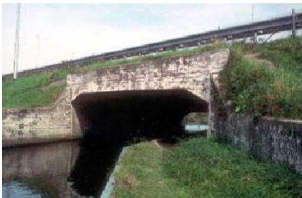
слика 12. Сувоземни пролаз испод моста
