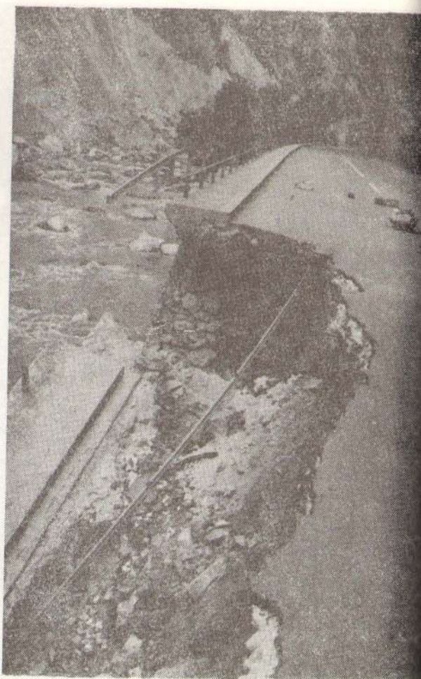
Сл. 4 — Оштећења од поплава већег обима 1965. године на путу бр. 5/1 Овчарско-Кабларска клисура.
