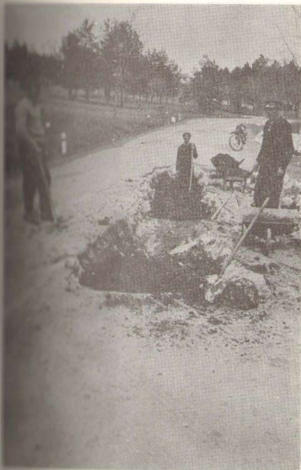
Сл. 3 — Поправка оштећеног коловоза због дејства мраз
