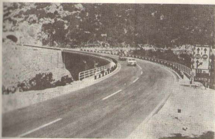
Сл. 1 — Ујтин тунел и мост
