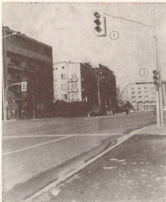
Сл. 4 — Возачка висећа лантерна пречника 300 мм (1) понављач пречника 300 мм (лантерна с леве стране) и возачка стубна лантерна пречника 210 мм (3)
