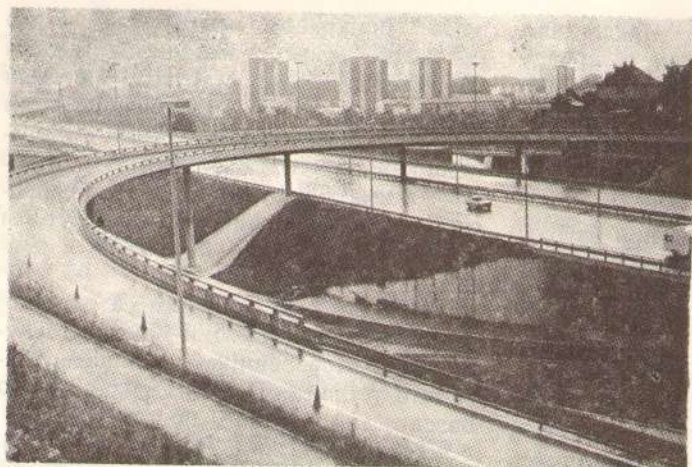
Сл. 3 — Пут број 2 на прелазу кроз предграђе Базела; железничка пруга је положена најниже, изнад ње је пут бр. 2, а изнад овог пута је један пут мањег значаја
