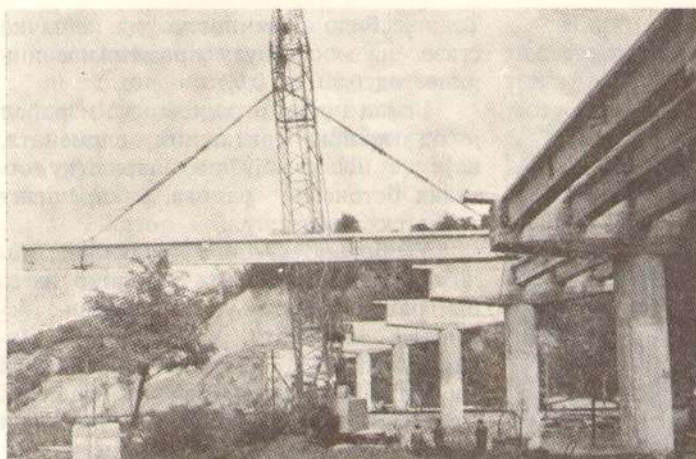
Сл. 6 — Монтажа носача
