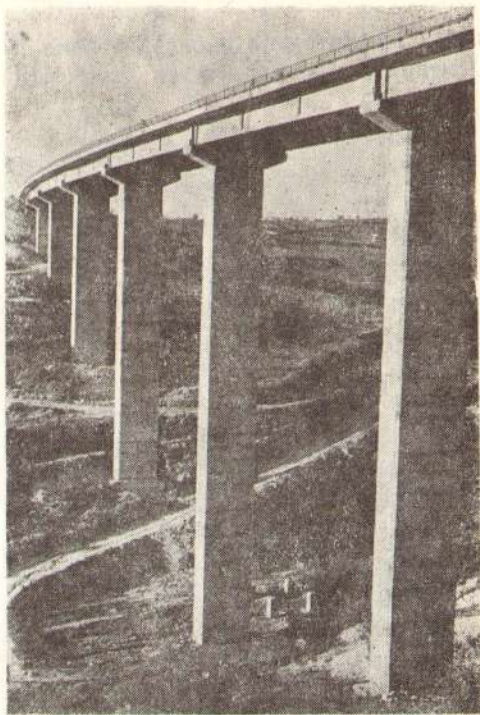
Сл. 7 — Друмски мост Дервенски поток — изглед одоздо
