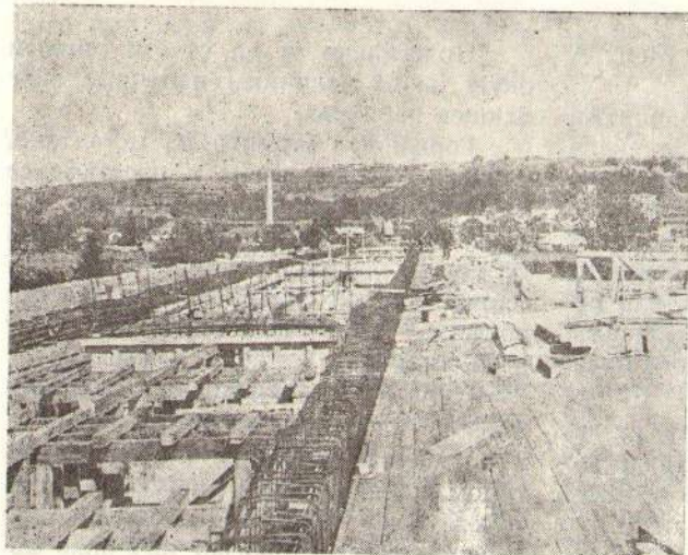
Сл. 7 — Арматура подужних и попречних ребара са кабловима
