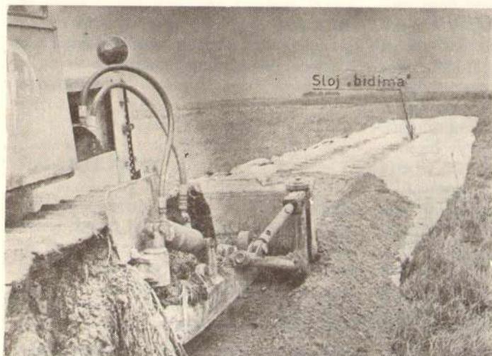
Сл. 1 — Слој „бидима“ положен преко расквашеног и мочварног терена преко кога се булдожером разастире слој песковитог шљунка.
