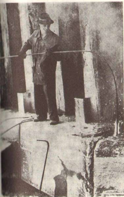
Сл. 2 — Сечење армиранобетонског појаса на прибоју од челичних талпи
