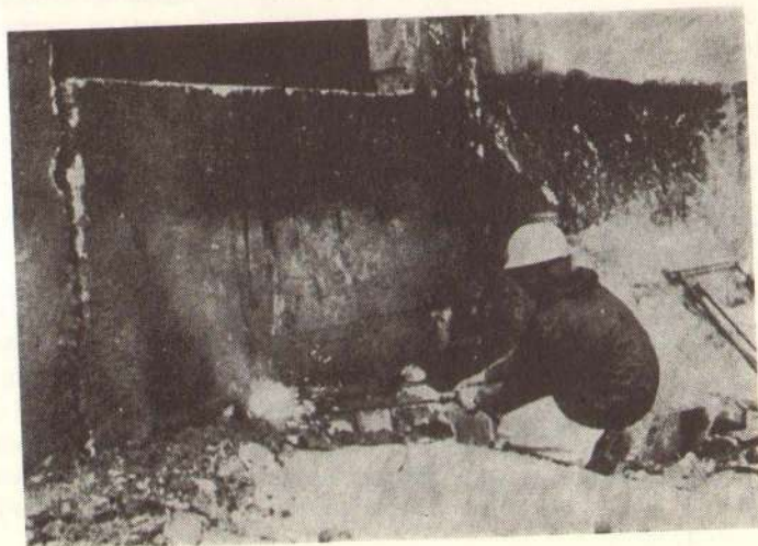
Сл. 3 — Сечење отвора у армирано бетонском зиду дебљине 60 cm
