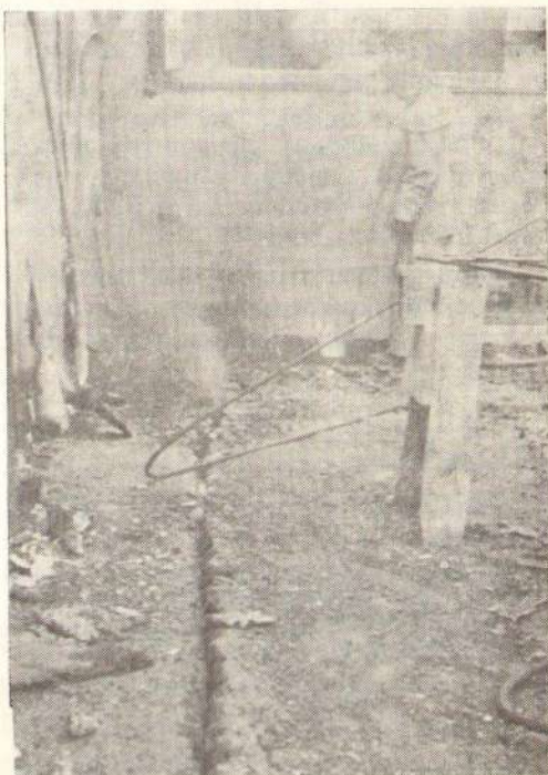
Сл. 6 — Вертикално сечење цементно-бетонске плоче
