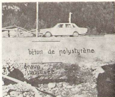
Сл. 6 — Ивица коловозне конструкције опитног поља 55 III; на дну је слој стабилизваног шљунка, а преко њега слој стиропор-бетона (асфалтни застор још није постављен)
