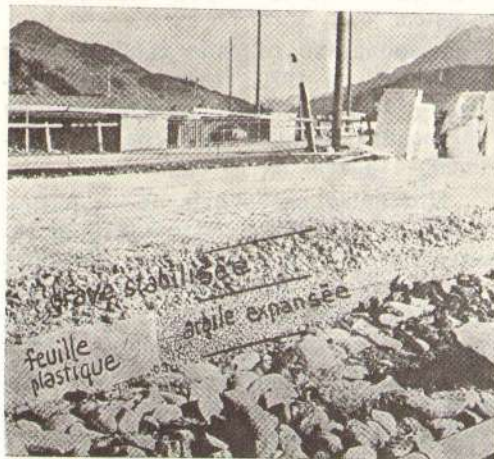
Сл. 5 — Ивица коловозне конструкције опитног поља 60 II; слој експандиране глине (у ствари ослонац за ивичну траку) израђен је преко слоја стабилизваног шљунка; лево, пластични покривач зрна од експандиране глине
