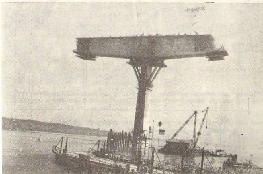
Сл. 11 — Изградња носеће конструкције слободним конзолним бетонирањем (мост преко Дунава код Бешке)
