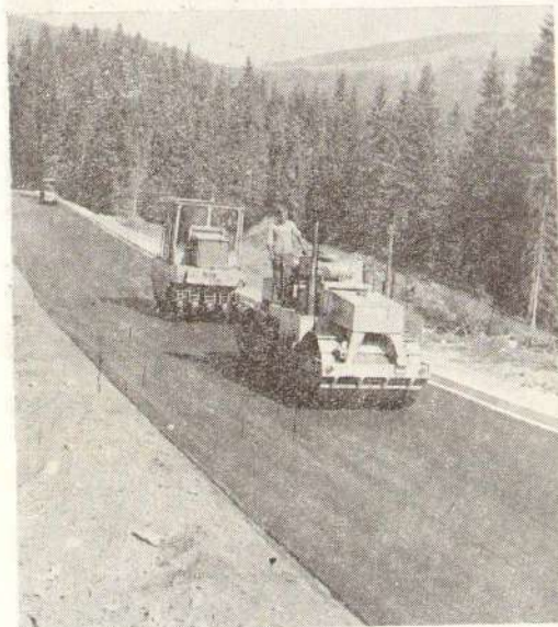
Сл. 8 — Ваљање асфалтног коловоза на km 12+050
