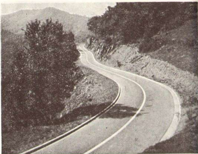
Сл. 4 — Изглед пута на km 8+200
