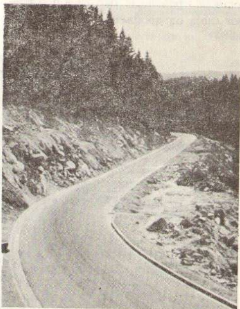
Сл. 3 — Изглед пута на km 21
